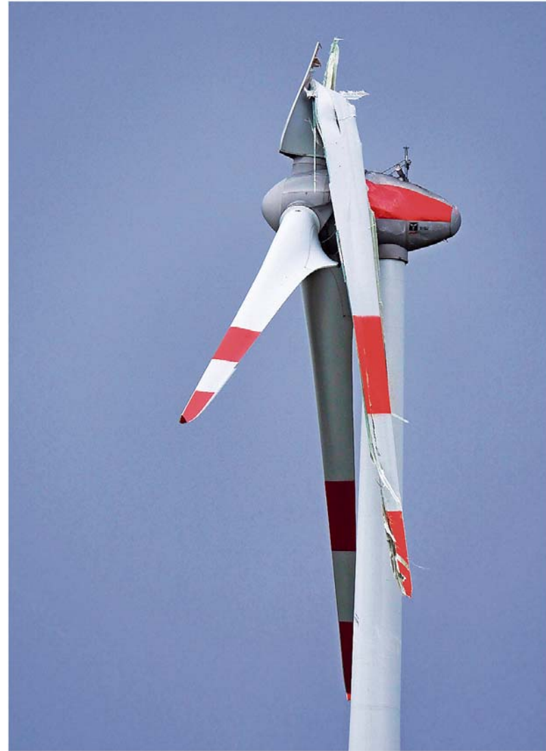
Dieser Schaden an einem Windrad an der A 62 nahe Freisen, verursacht durch einen Blitzschlag, hat eine Sicherheitsdebatte ausgelöst. FOTO: B & K
